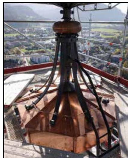
Le support de la croix entièrement rénové
